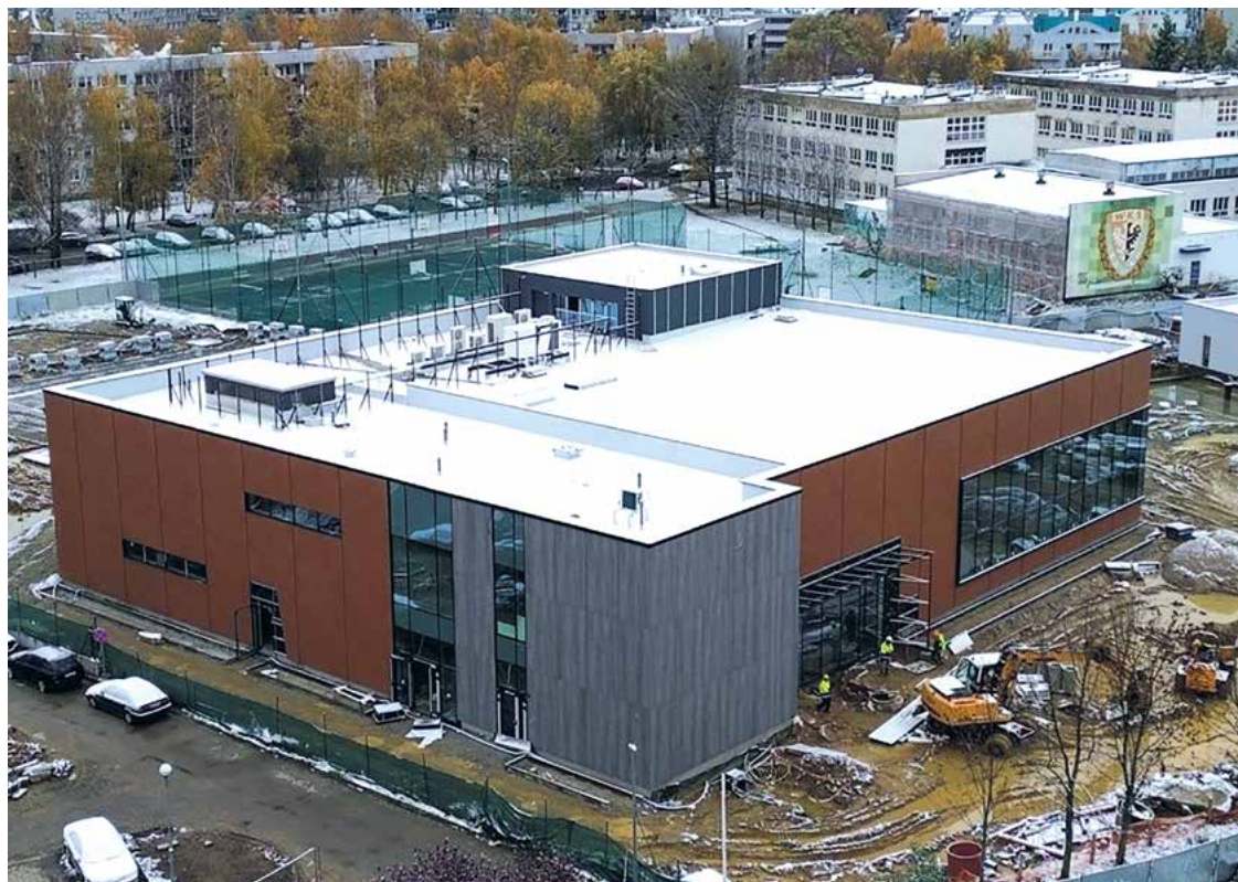
Prace przy budowie centrum basenowo-sportowego przy ul. Wilanowskiej we Wrocławiu dobiegają końca
